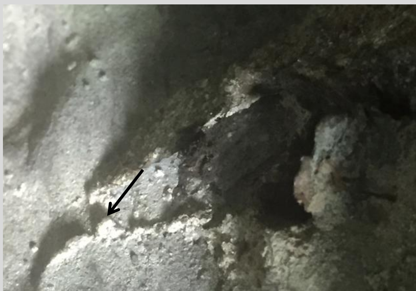
Détail de la paroi interne. La flèche indique de fines traces parallèles de lissage.
